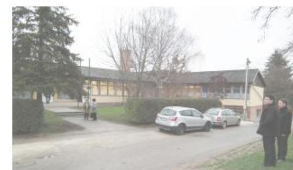
Iskola utca, Forrá épületszárny
